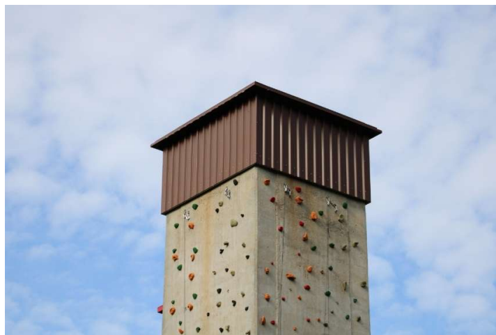
Bild 6 Pfeilerkopf mit Abdeckung als Unterschlupf für Fledermäuse (Weber Robin)
